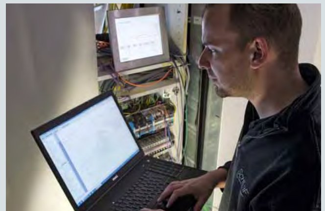
6 Inbetriebnahme der Elektrik und IT.
