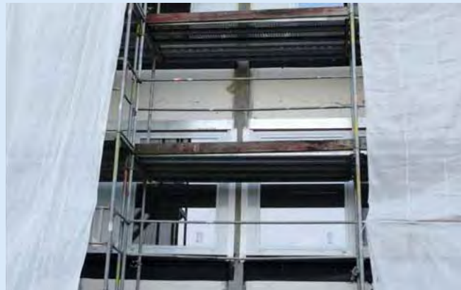
6 Fenstereinbau auf der Rückfassade am 06.11.2012 (Fotos: Annette Maurer).
