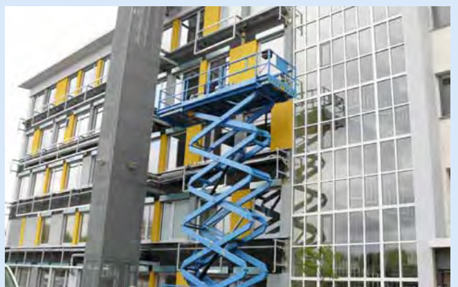
9 Installation der Verkleidung am 15. April 2014.
