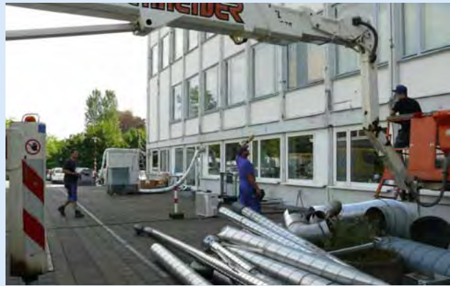
2 Demontage der Installationen an der Rückfassade ab 05. Juli 2012.
