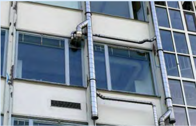
1 Detailansicht der Rückfassade mit Rohrleitungswildwuchs, der nun geordnet werden konnte.
