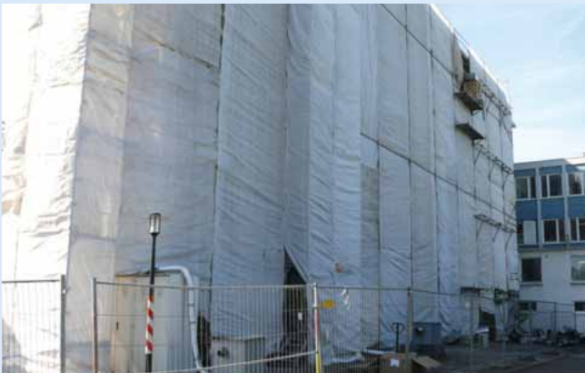
5 Gerüstbau und Umhüllung der Baustelle am 23.07.2012.
