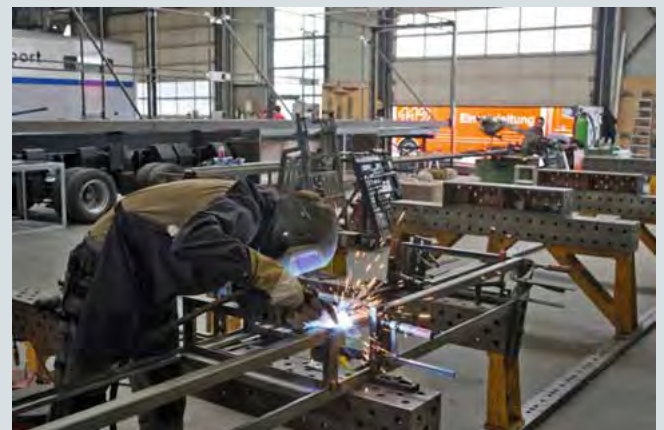
2 Schweißen des Chassis.
