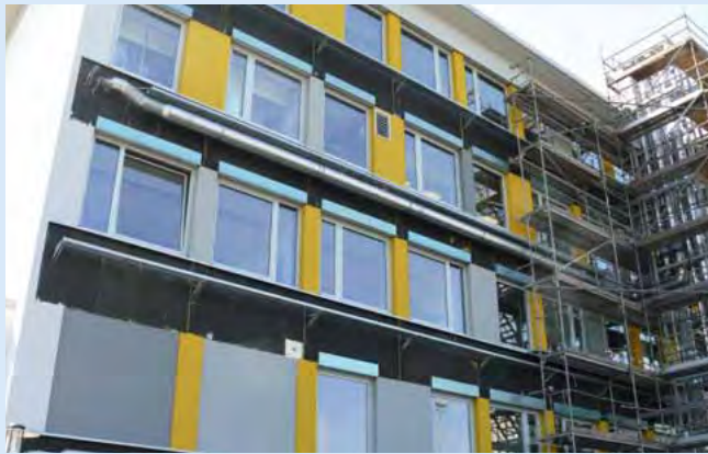
7 Rückbau des Gerüsts am 17. Juni 2013.
